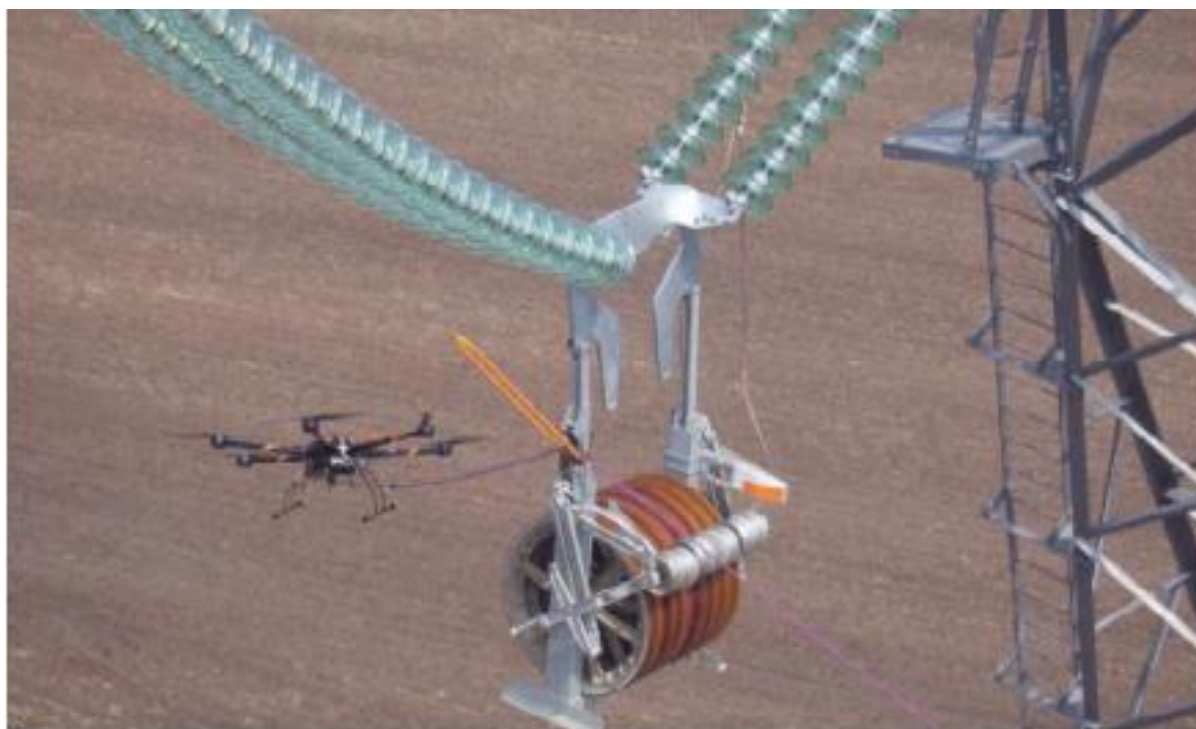
Figura 2-3: Opção de “stringing” através de drone
